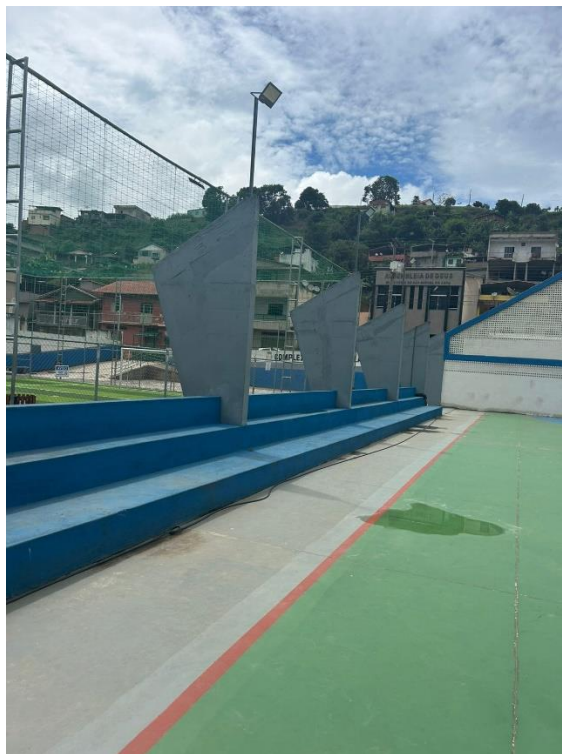
Figura 11 – Pilares trapezodais executados Fonte: elaboração própria.
