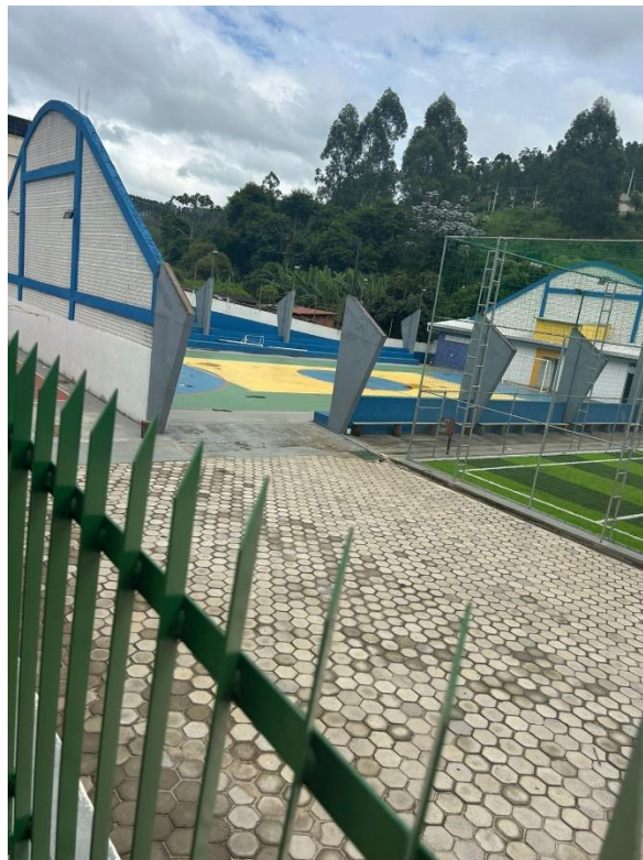
Figura 3 - Vista lateral do terreno da quadra Fonte: elaboração própria
