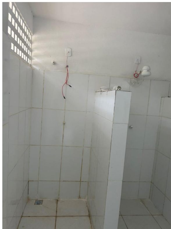
Figura 9 – Chuveiros não finalizados Fonte: elaboração própria.
