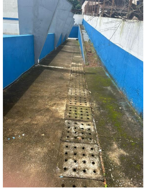
Figura 16 – Canaletas de drenagem pluvial executadas - Fonte: elaboração própria
