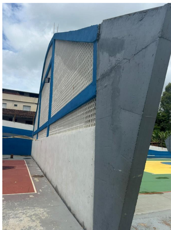
Figura 14 – Pilar para receber estrutura metálica Fonte: elaboração própria.
