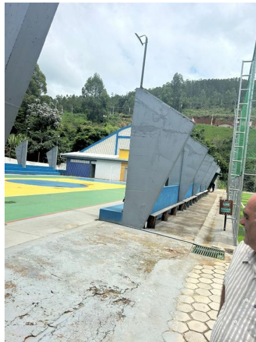
Figura 12 – Pilares trapezodais executados Fonte: elaboração própria.
