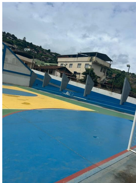
Figura 15 – Piso da quadra executado - Fonte: elaboração própria
