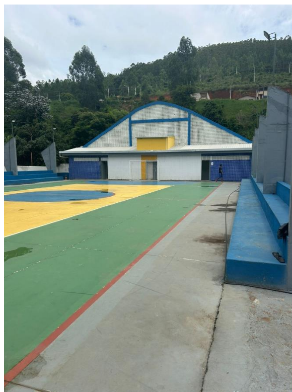
Figura 4 - Vista frontal do terreno da quadra - Fonte: elaboração própria
