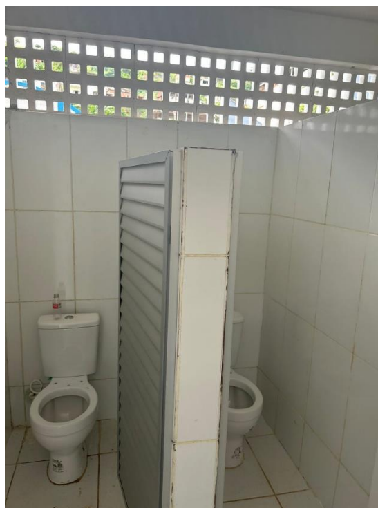
Figura 8 – Sanitários executados com caixa acoplada - Fonte: elaboração própria.
