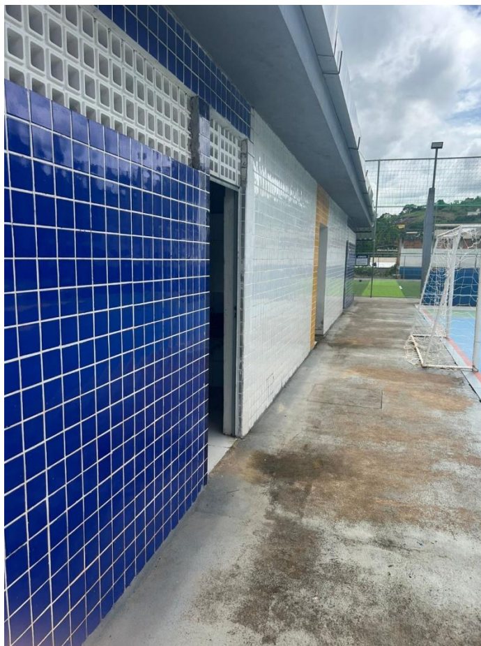
Figura 6 – Elemento vazado executado no local das bandeiras de vidro. Fonte: elaboração própria
